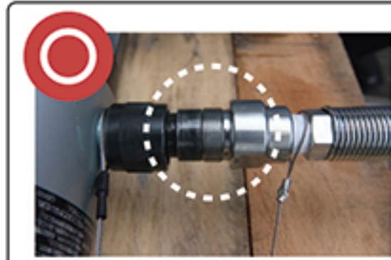
カプラー差込みの良い例 ねじ部分に隙間なし
