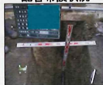
配管布設状況
