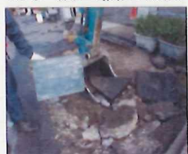
ガラ・残土積込状況
